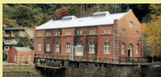
旧端出水力発電所
